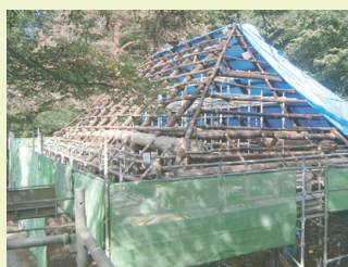
解体工事見学会
