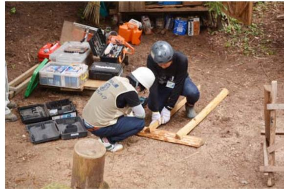
できたサインを建てるために、支柱を取り付けています。細い杉丸太の皮をむいて、防腐剤を塗って、サインとビス留め。
