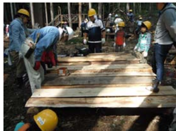
床板敷並べ、固定。
