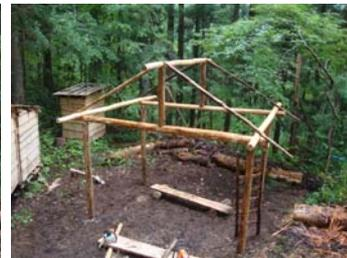
墨出しをして立てた柱に、梁、桁、束、棟木を取付け、1日で小屋の骨格が完成です。この小屋は、間口3m、奥行き2mで切妻屋根の小屋になります。
