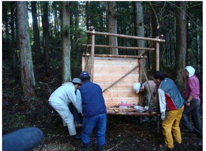
前回に引き続き、道具小屋の製作をしました。全体を移動させて、使いやすい位置に据え付けました。壁に板を打ち付け、補強しました。次回は、扉と屋根をつけます。
